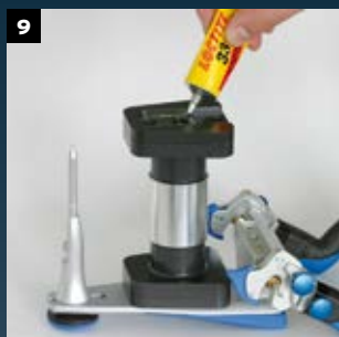
9 Splitexplatte mittig mit zwei Kleberspuren versehen
